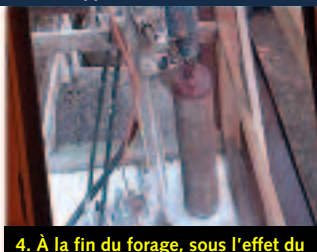
4. À la fin du forage, sous l'effet du poids de la carotte, l'appareil se bloque contre la paroi de l'outil diamanté et empêche la carotte de béton de chuter.
