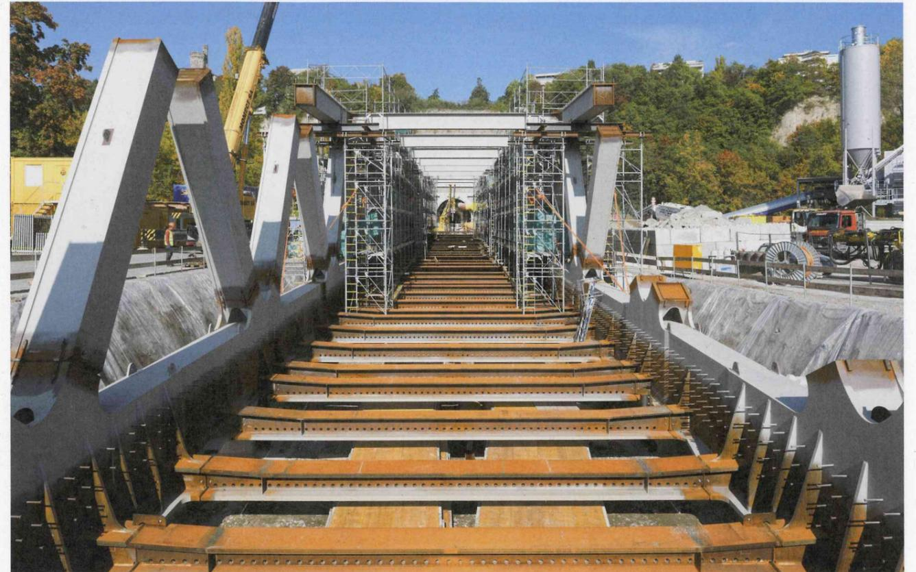
Les derniers préparatifs avant le poussage vont bon train. L'assemblage sur site des plus de 1000 tonnes d'acier est en cours de finalisation. La structure est actuellement peinte et soudée. Quant à la rampe de lancement, elle est quasiment prête. Ces prochaines semaines seront consacrées à construire un avant-berc sur la rive gauche de l'Arve.
