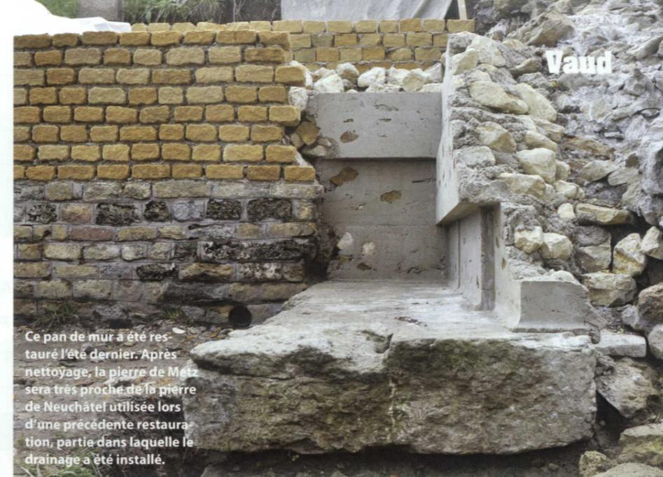
Ce pan de mur a été restauré l'été dernier. Après nettoyage, la pierre de Metz sera très proche de la pierre de Neuchâtel utilisée lors d'une précédente restauration, partie dans laquelle le drainage a été installé.
